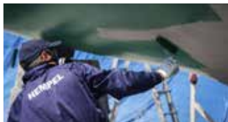
Applicera bottenfärg över grundfärg eller häftgrund
